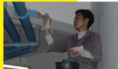
※ 管道油漆翻新
