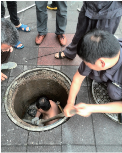
※ 徒手下井疏通排污管
